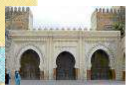
2. FEZ. Era la conexión entre al-Ándalus y la ruta caravanera. La imagen muestra una plaza junto al palacio real, en el barrio de Fes el-Jdid.
